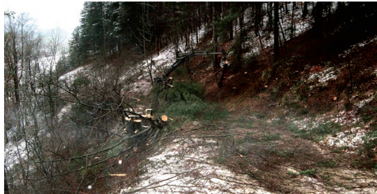
Travaux forestiers aux Sâces, hiver 2007-2008
