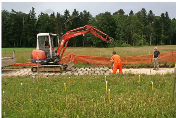
Fig. 4 Construction du chemin groisé avec les traverses CFF en béton-métal
