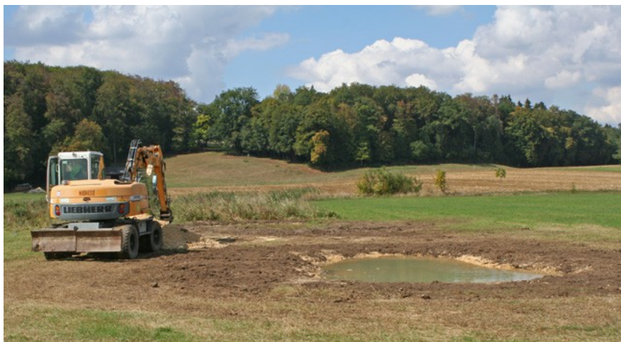
Fig. 0. Travaux d'étanchéification aux Méchières, près de la Coeuvatte, septembre 2018
