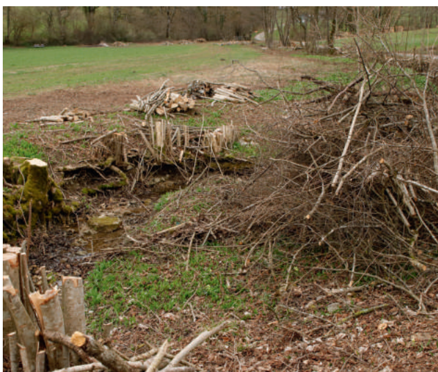
Le Biel de Val à Vicques a subi une dégradation des berges boisées.
