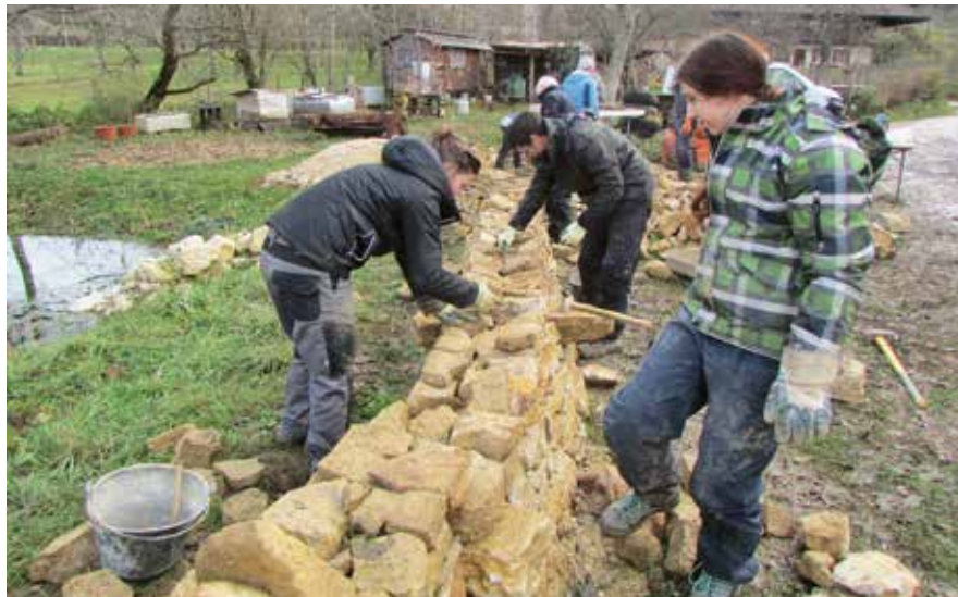
Construction d'un écomur au Martinet en bordure de la nouvelle mare.
